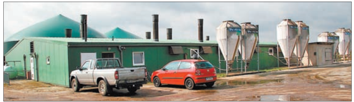
Erfolgsgeschichten: der Stall für 200 Sauen. Die Biogasanlage dahinter liefert die Wärme.
